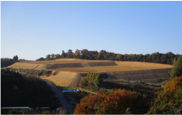
傾斜がきつく管理作業に不利な条件を改良するため、再整備を実施したほ圃の様子
