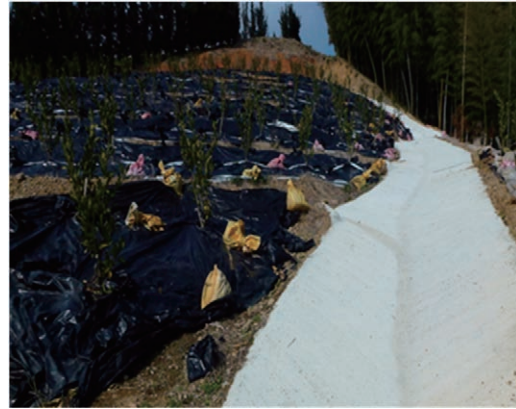
(園内道整備後の状況)
