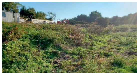
写真Ⅱ-3-2 基盤整備事業(戸田地区)
