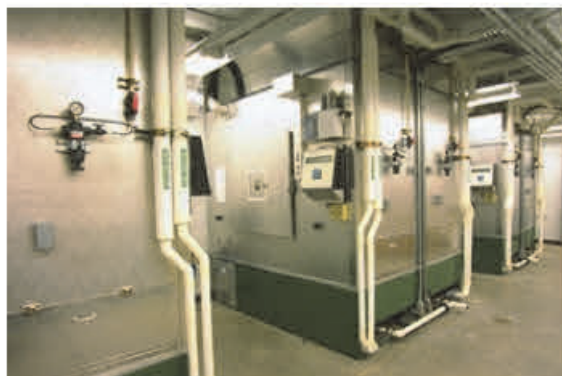
温度・光量・湿度は8つの植物生育室ではコントロールされている。
