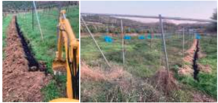
バイオ炭の埋設状況（キウイフルーツ）
