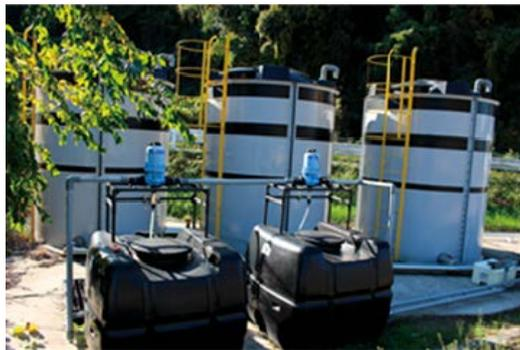
写真5 共同で利用しているタンクと液肥混入機
