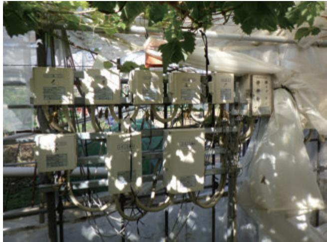
写真2 天窓の自動開閉装置
