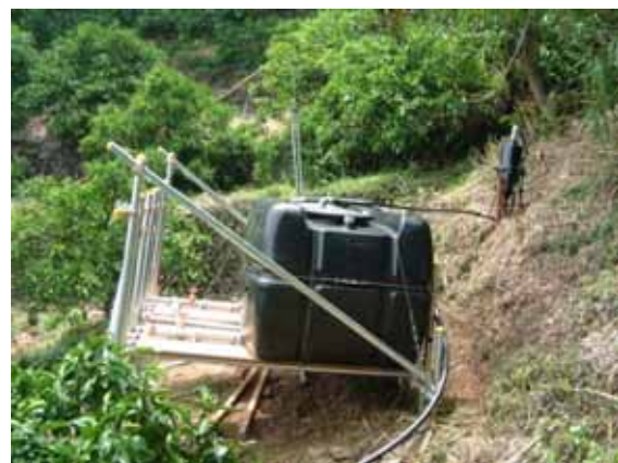
簡易貯水タンクの設置
