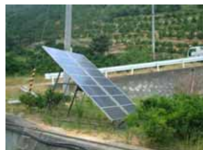
法面からの雨水貯水槽
