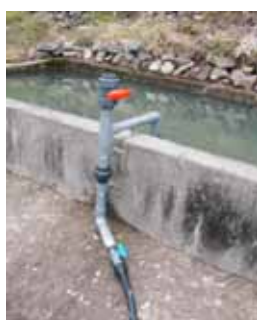
コンクリート貯水槽
