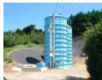
園地内貯水タンク
